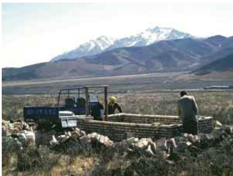
Construction de la station TIA
